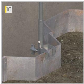
Staal constructie bevestiging
